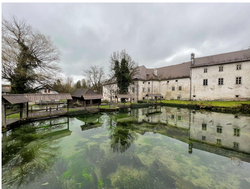
Slika 1. Izvirno območje Bistre; november 2022 (Foto: U. Pavlič) Figure 1. Bistra springs area; November 2022 (Photo: U. Pavlič)
