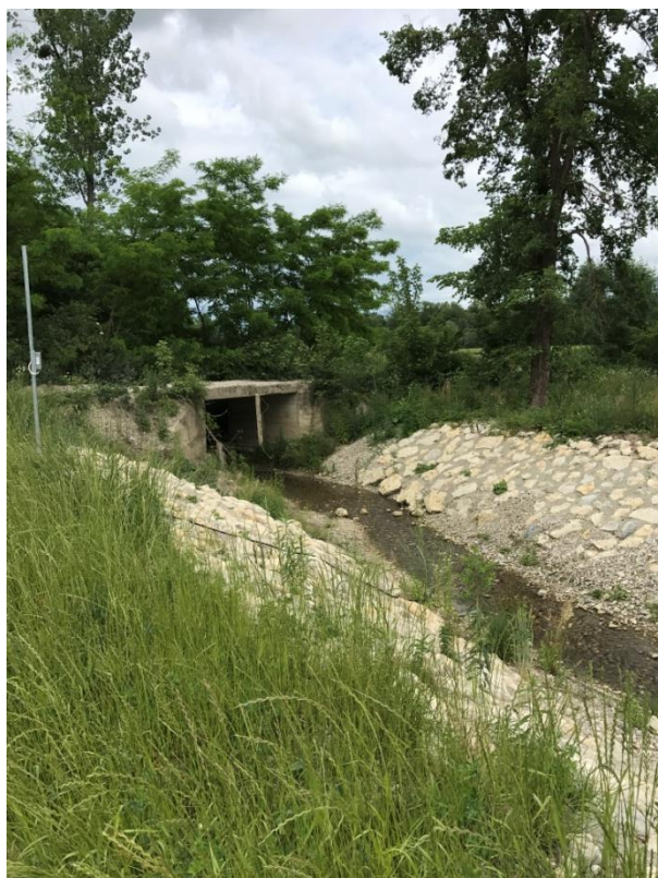
Slika 3. Odvod podzemne vode vodonosnika Krškega polja, projektiran ob izgradnji jezusa hidroelektrarno Brežice (Foto: Urška Pavlič)
