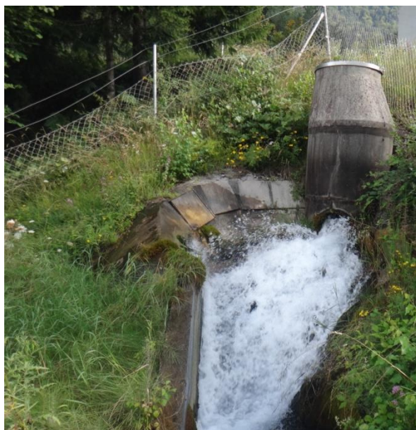
Slika 1. Merilna postaja za spremljanje iztoka podzemne vode iz cestnega tunela Karavanke (Foto: Arhiv ARSO) Figure 1. Measuring station for groundwater discharge measurements from road tunnel Karavanke (Photo: ARSO archive)
