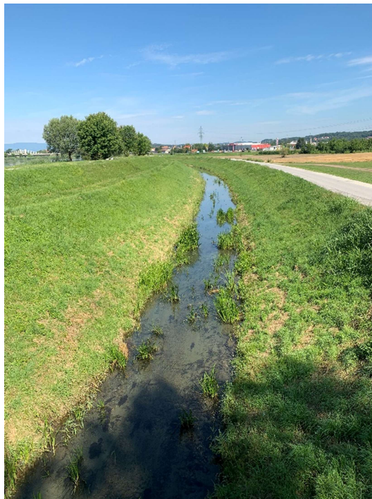
Slika 2. Drenažni kanal vzdolž Ptujškega jezera, v katerega se poleg jezerske vode steka tudi podzemna vode iz vodonosnika Ptujškega polja; julij 2020
