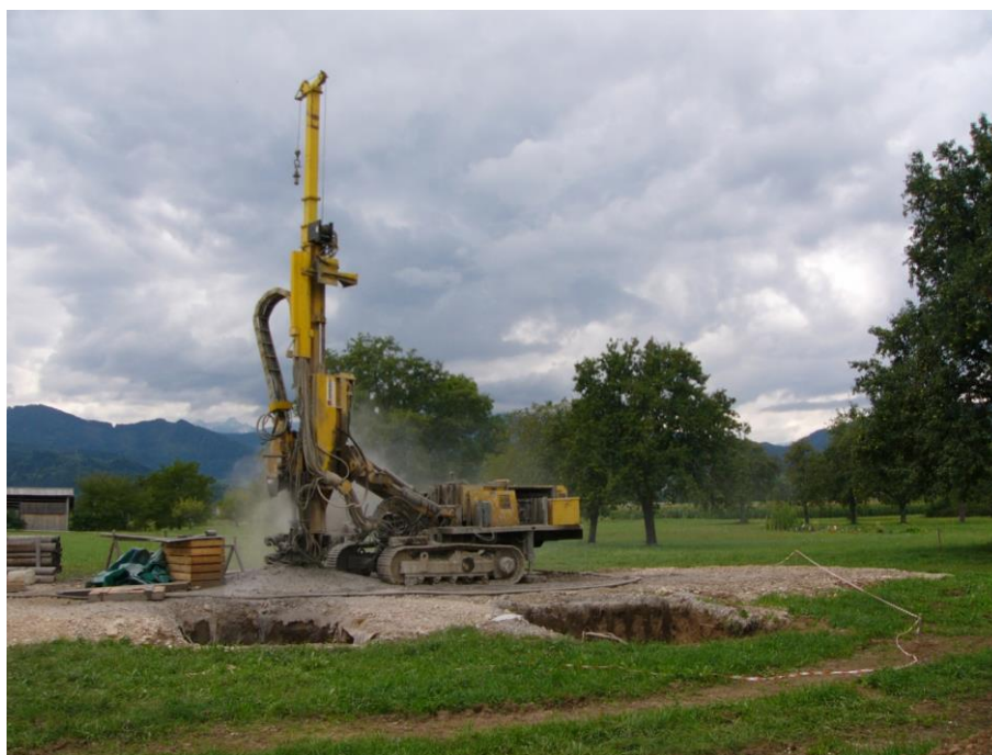
Slika 1. Vrtanje piezometrične vrtine na Bledu v septembru 2013; foto: V. Savić Figure 1. Piezometric borehole drilling in Bled, September 2013; Photo: V. Savić
