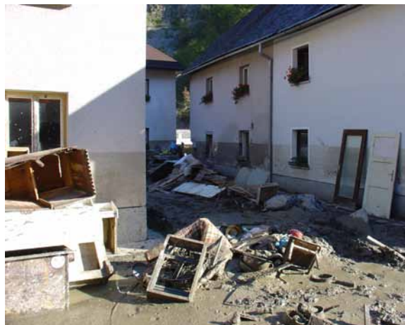
Slika 5. Uničenje v železnikih po poplavi Selške Sore 18. septembra 2007 in sled visoke vode na prizadetih objektih (foto: M. Burger)
